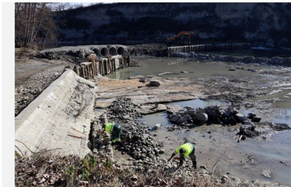
Operaris iniciant els treballs a la resclosa de Can Buxó, una de les que es retirarà | Mar Martí / ACN
