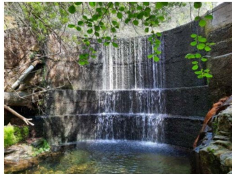
Mur de la resclosa de la font del Vern.
